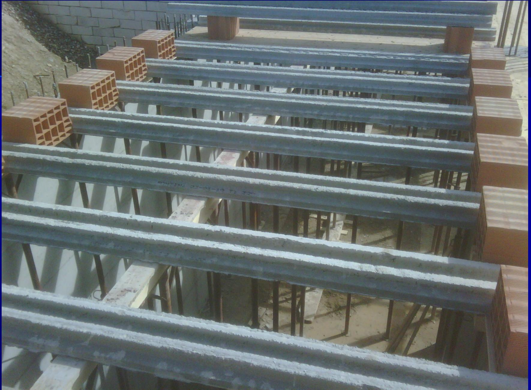
**Le fasi della costruzione .... Solaio pronto per il getto del calcestruzzo**
