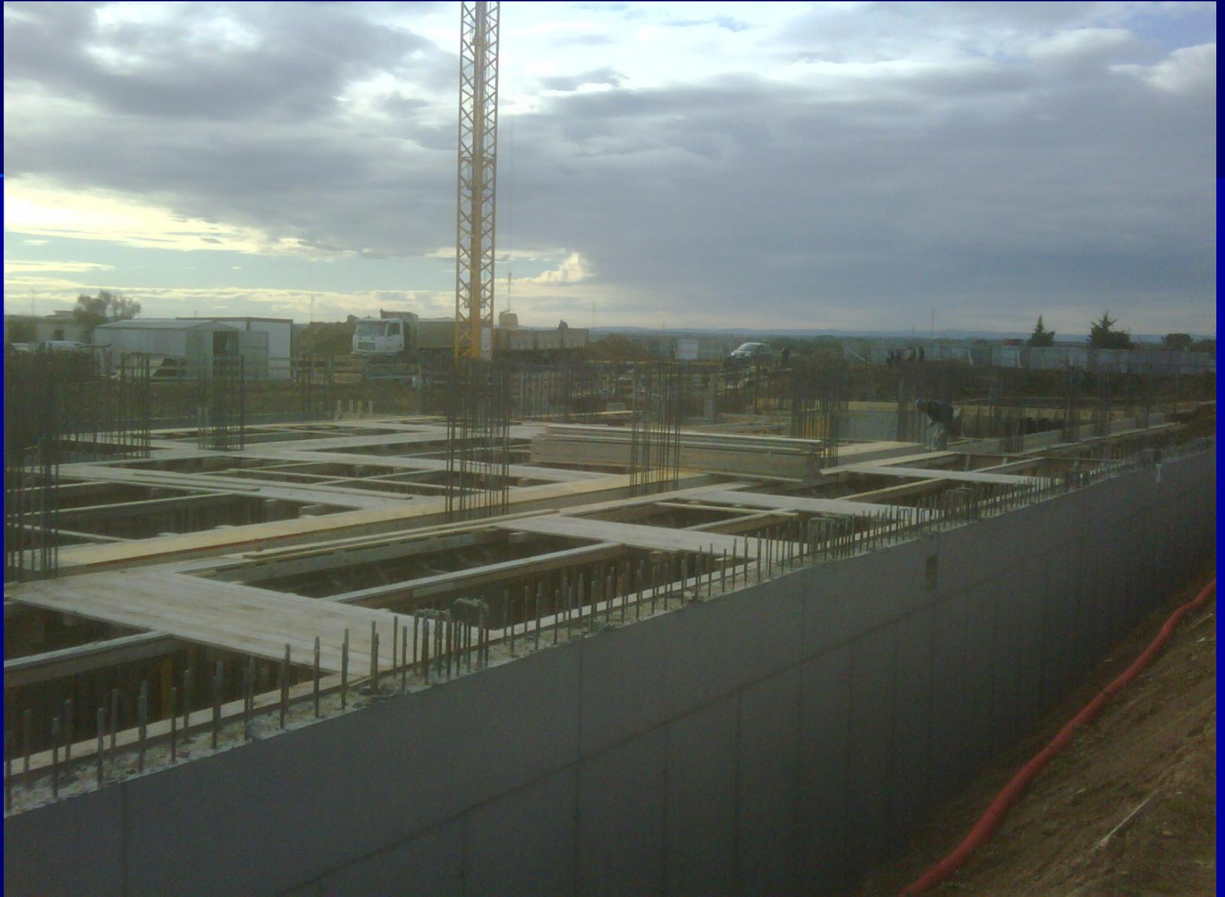
**Le fasi della costruzione .... Preparazione del solaio e delle travi sui pilastri**
